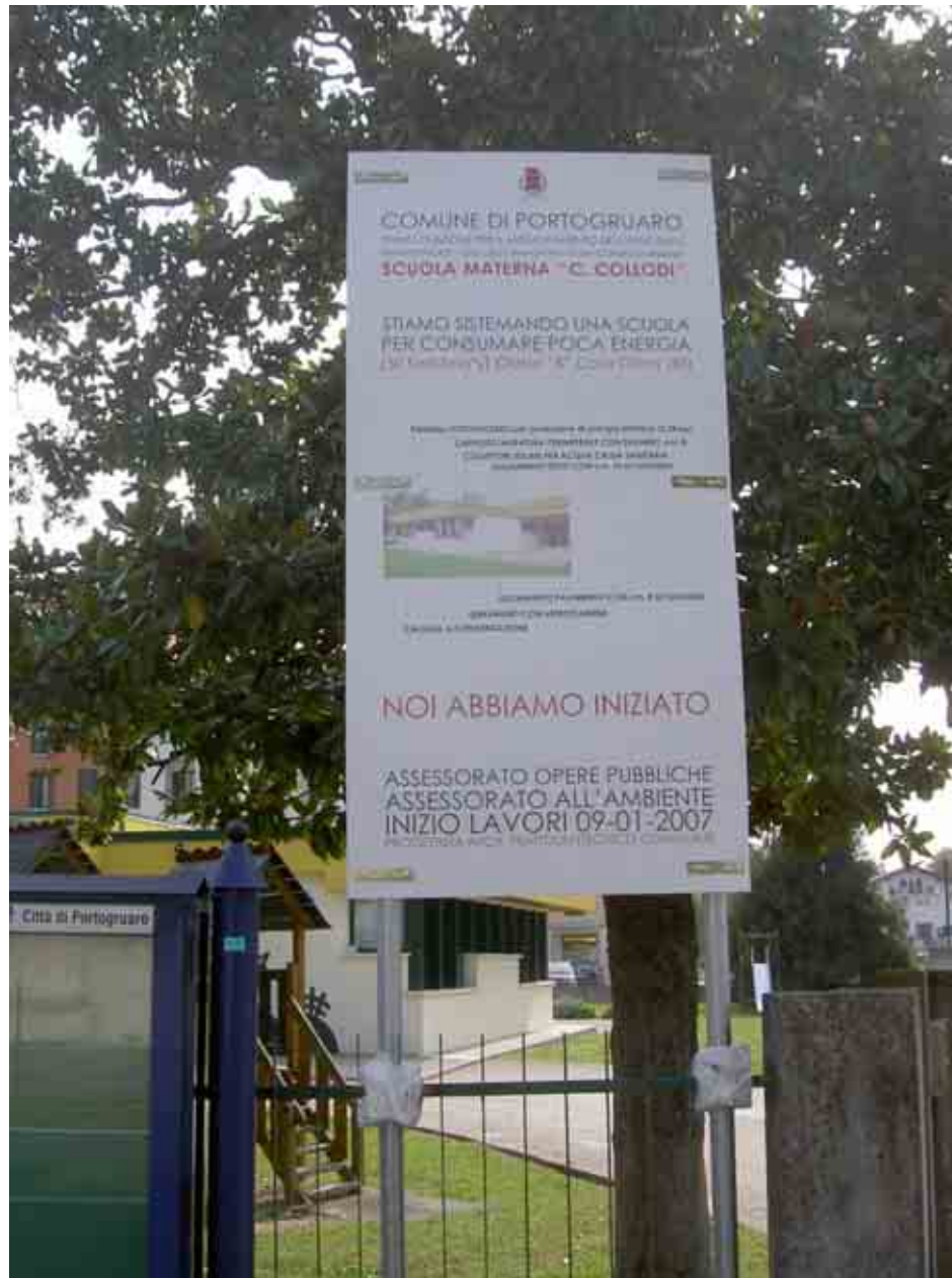
Cartello informativo ubicato all'ingresso del cantiere
